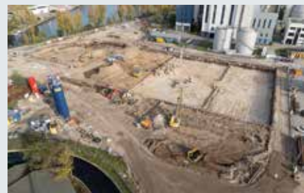
Saubere Sache: Am Spree-Ufer in Berlin-Ruhleben entstehen zwei neue Anlagen, in denen das Abwasser von rund 1,6 Mio. Menschen noch effektiver gereinigt werden soll. (Foto: Porr)
