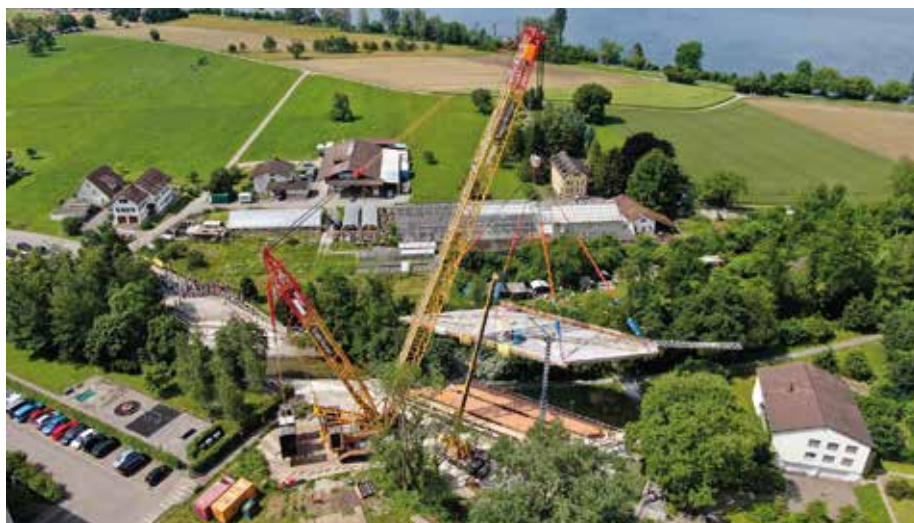
Gleichmäßige Lastverteilung: Da beim Einhub der Aabach-Brücke die maximal zulässigen Kräfte an den Anschlagpunkten exakt eingehalten werden mussten, wurden Litzenheber in die Anschlagmittel integriert. So konnte jedes Seil individuell angesteuert werden. (Foto: Tadano)
