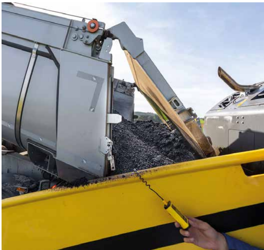
Vorteilhaft: Durch den Einbau Temperaturgesenkten Asphalts lassen sich Energie, Emissionen und Zeit einsparen. (Foto: Bomag)
