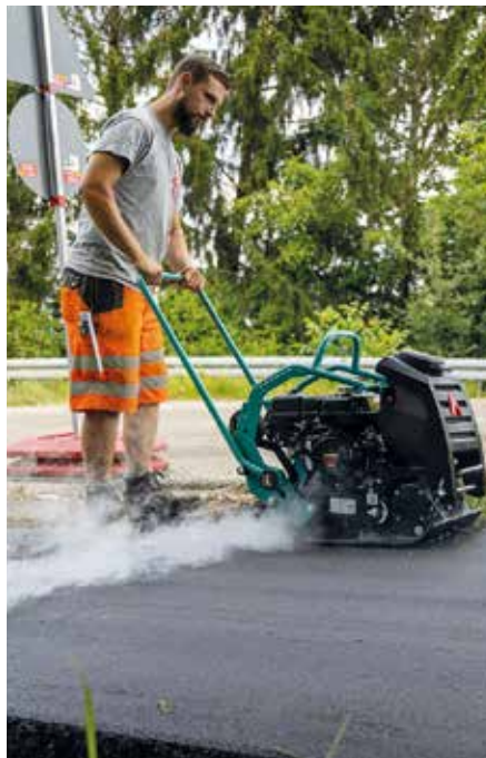
Vielseitig: Die APF 15/50 bearbeitet mit der optionalen Berieselungsanlage auch Schwarzdecken. (Foto: Ammann Verdichtung GmbH)
