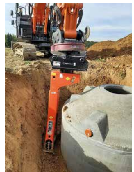
Hochpräzises Arbeiten: Dank des RotoTop sind sämtliche Anbaugeräte flexibel und drehbar. (Foto: Holp)
