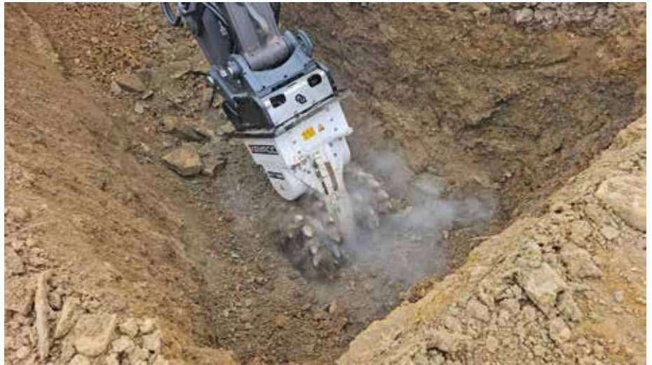
Leistungsstark: Der Großbagger war mit der Querschneidkopffräse EKT 220 vom Kemroc ausgerüstet, um große Mengen an festem Dolomitgestein im Untergrund zu lösen.
